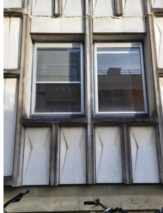
Les fenêtres du bâtiment s'apprêtent à être démolies, dont l'équipe a décidé de réemployer les menuiseries aluminium. © Les Animé·e·s
