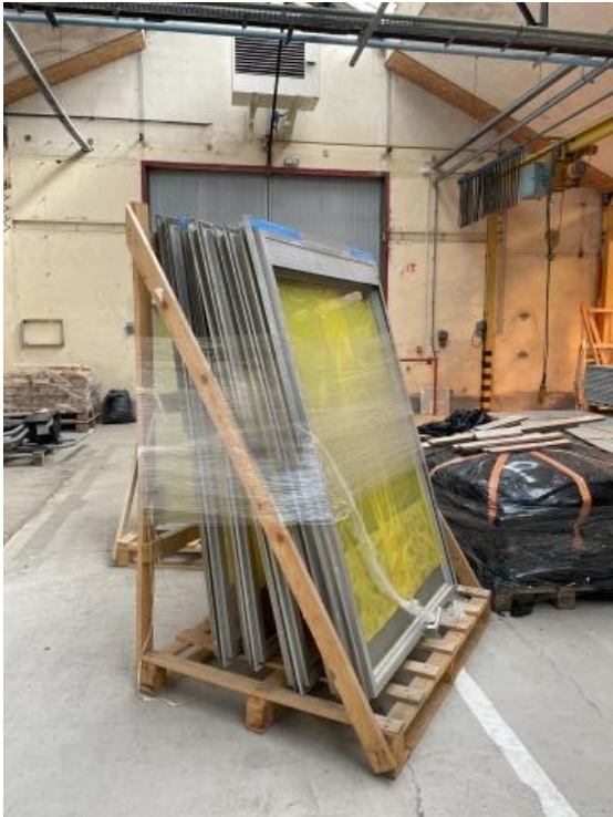
Les fenêtres du bâtiment s'apprêtent à être démolies, dont l'équipe a décidé de réemployer les menuiseries aluminium. © Les Animé·e·s
